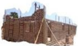
Nuova scuola in costruzione a Matekaga
